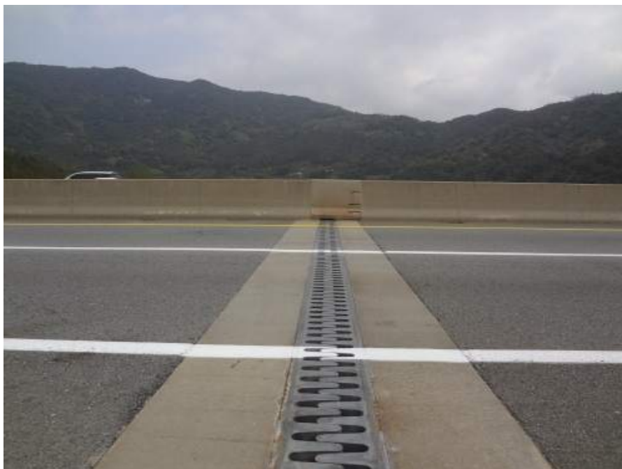
신축이음장치 전경(P8, 부산)
