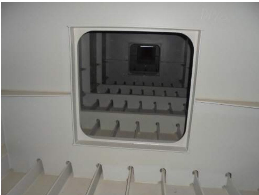
거더 내부 전경
