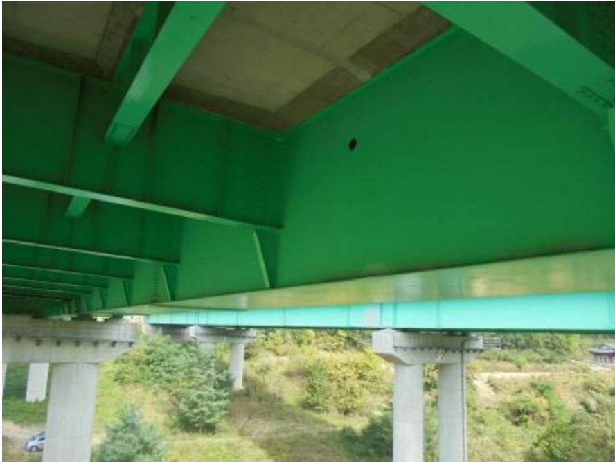
거더 외부 전경
